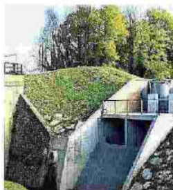
Un impianto idrovoro
