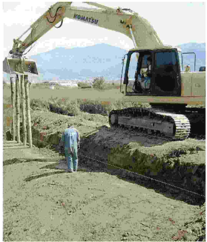
Operai al lavoro sull'argine di un torrente per interventi sulle sponde
