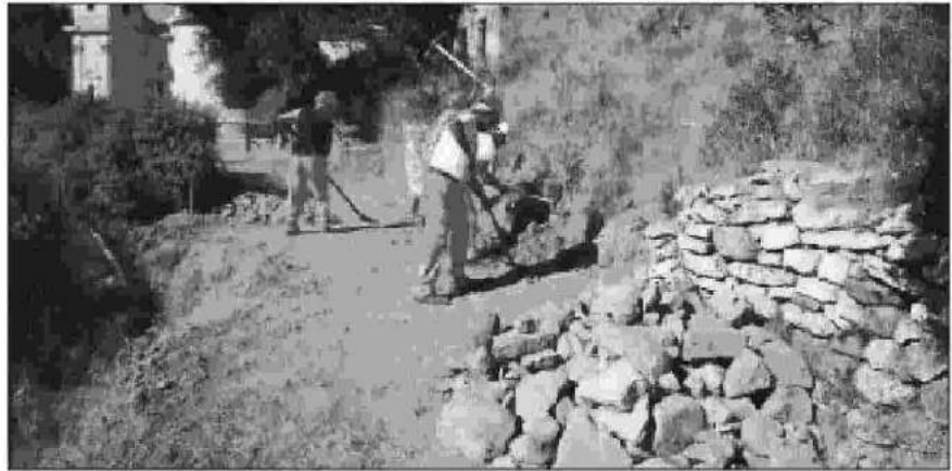
Operai del consorzio al lavoro
