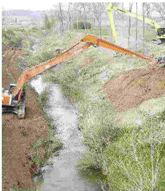
Ruspe al lavoro sull'Ombrone, ma i cantieri sono ancora in ritardo sulla tabella di marcia
