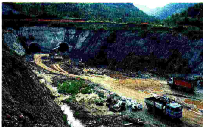
Il cantiere. Gli imponenti lavori della diga dovranno essere rifinanziati
