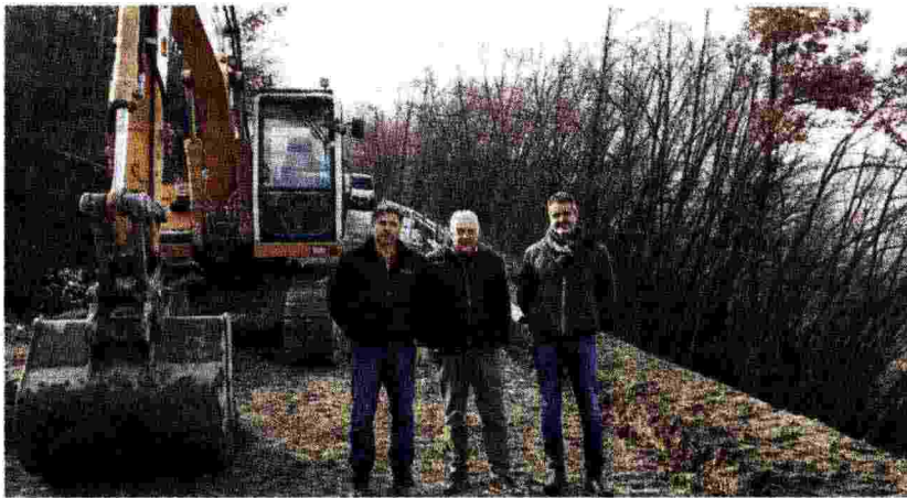
Tizzano Fattori, Bodria e Malcotti sul cantiere stradale.
