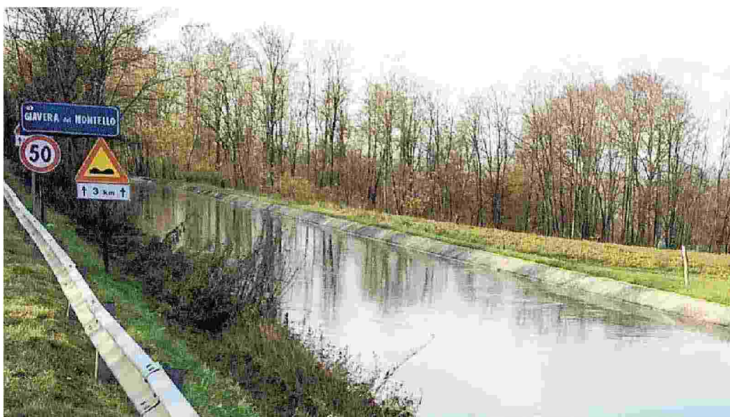
Canale di derivazione a piena portata, in questi giorni invernali, a Giavera: alimenta canalette e centraline elettriche
