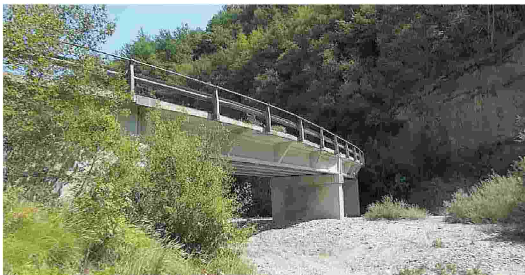
Il ponte sul torrente Boreca, sulla provinciale di Zerba: lavori assegnati a una ditta di Bobbio FOTO DESTRI
