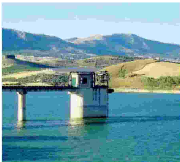
Nella diga Castello di Bivona si trovano ancora invasati ben 12 milioni e mezzo di metri cubi d'acqua
