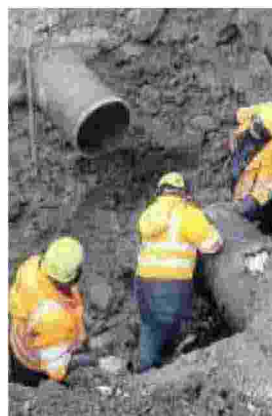
INTERVENTO Manutenzione anti allagamenti sulla rete idrica
