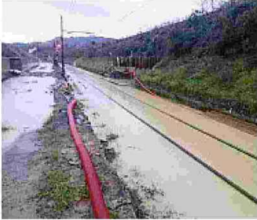
Il tratto di ferrovia allagato nel pistoiese; in alto, l'auto incastrata
