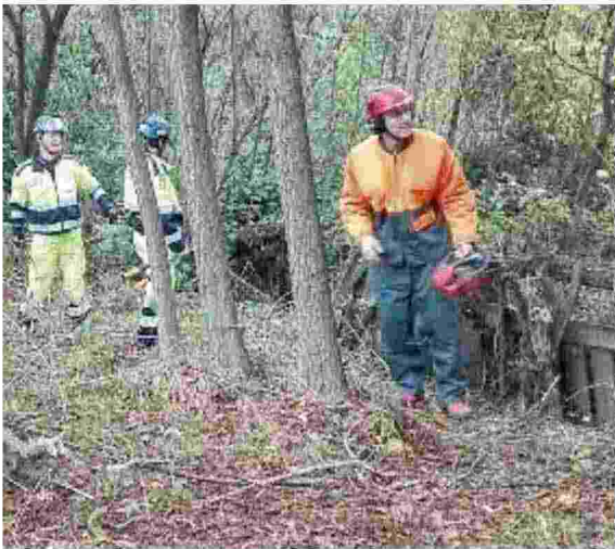
TORRENTI In corso la ripulitura sui borri per limitare gli effetti di eventuali inondazioni
