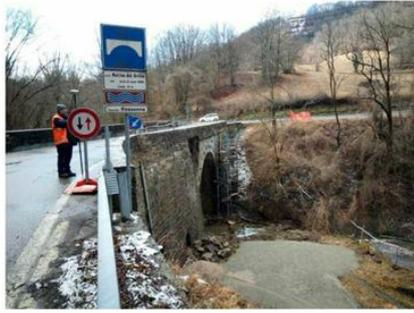
A Lama Mocogno sul ponte Mulino del grillo, sul torrente Rossenna, sono partiti nel pomeriggio di mercoledì 4 marzo i lavori di manutenzione per riparare il cedimento del paramento laterale che si è verificato martedì 3 marzo a causa del maltempo.
