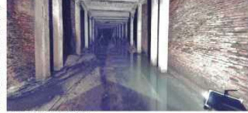
Un tratto interrato del torrente Cesuola
