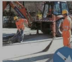
A settembre previsti diversi cantieri della Latis.
