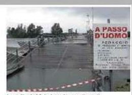
Il ponte di Staffa di Gorino è stato chiuso per la piena
