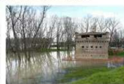
A Staffala, vicino Pesente, struttura di legno lungo il fiume, a Pontelagoscuro
