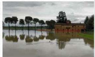
Casa della Ghilana con il progetto di lottizzazione del 17 maggio subito dopo l'alluvione
