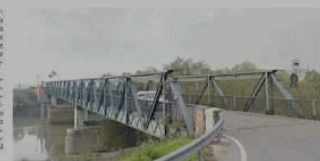
Riparte la manutenzione del ponte Ariano Ferrarese e Ariano Polesine, oltrepassando il Po di Reno
