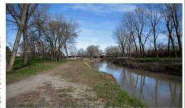
La sponda sinistra lungo la via Cristoforo Colombo in direzione del ponte di via Pisacane (clicca qui)
