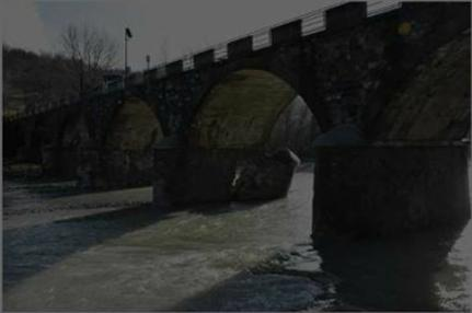
Sul ponte Samone, lungo la strada provinciale 26, chiuso da domenica 6 dicembre a causa del cedimento parziale di una pila di sostegno, provocato dalla piena del fiume Panaro, la Provincia ha effettuato in questi giorni una serie di prove penetrometriche profonde oltre 30 metri della struttura del terreno sottostante
