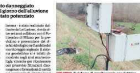
Colorno: il sistema di monitoraggio geoelettrico.
