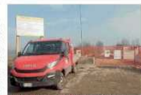
SQUADRE DI LAVORATORI IN AZIONE. Sono in corso
