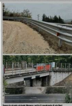
Sopra la strada vicinale Mesera, sotto il cavalcavia di via Neri
