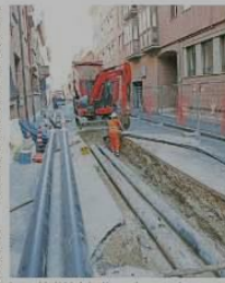
La posa dei tubi del teletrasmissione in cassetto stadi
