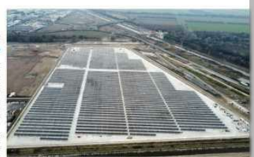
Il parco fotovoltaico entrato in funzione
