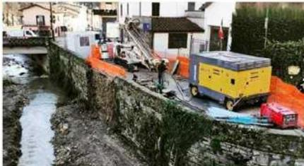
**S**ono iniziati (finalmente) i lavori di ripristino del muro di sponda del torrente Rio, dopo che a primavera parte del muro aveva subito un parziale dissesto. I tempi di avvio del cantiere si sono (molto) allungati a causa di indagini archeologiche richieste dalla Soprintendenza, che ci hanno costretto a ricercare e stanziare ulteriori risorse per incaricare un archeologo e per effettuare le indagini". Lo comunica su Facebook il Comune di Bagno di Romagna.
