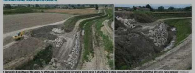
Il Consorzio di bonifica sta lavorando ogni giorno su diversi fronti per ripristinare la sicurezza Cicchetti: «Ricostruito l'argine destro ed eseguito un rivestimento con massi ciccopi cementati»
