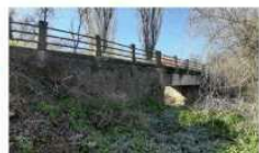
Il ponte sul Tavollo
